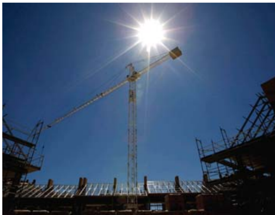
Viviendas en construcción en Madrid. EFE
